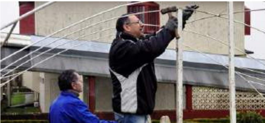
Fijamos los mástiles al suelo, compactando bien con piedras y tierra para que la sujeción sea muy fuerte, ya que el clima de Monterroso es extremo y, en numerosas ocasiones, se producen fuertes vientos, lluvias, etc. que podrían derrumbar la estructura en caso de que no estuviese bien fijada y anclada al suelo.
