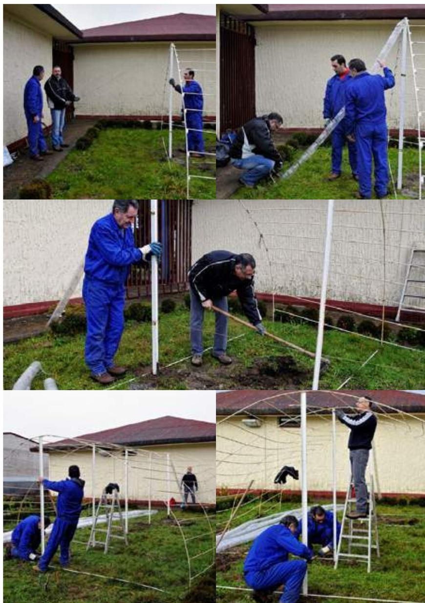
A continuación, fijamos las barras laterales a los arcos del invernadero. Para ello, en primer lugar, medimos en cada una de ellas la distancia al primer arco, para mantener la distancia equivalente durante toda la trayectoria de la barra, repitiendo el mismo paso en todas ellas.
