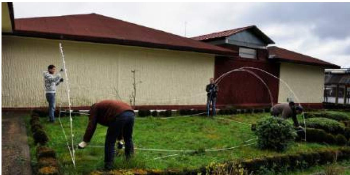
Tras colocar los arcos frontal y trasero, que se han unido con algunas barras laterales para dimensionar y presentar la estructura, se colocan los otros tres arcos interiores, que se han sujetado con alambre, por ahora de un modo provisional para que permita su movilidad.
