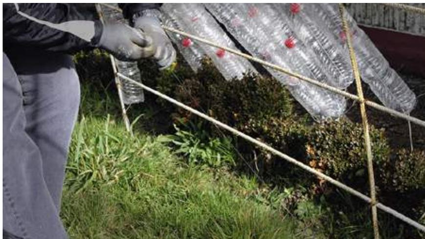
En el final de cada una de las hileras de botellas, anudamos un trozo de alambre que será el que se utilice para fijar cada fila en el alambre.
