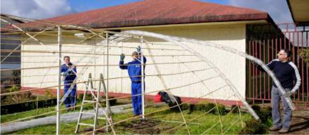
Tras ir presentando y colocando las primeras filas de botellas de la cobertura del invernadero, que ya explicamos en el apartado anterior cómo se iban entrelazando, se van ajustando y tensando con la cuerda interior para que adquieran la estructura adecuada y ajusten perfectamente unas con otras.
