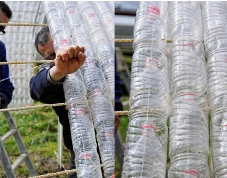
En la parte inferior de los laterales del invernadero, fijado a los arcos, colocamos un alambre siguiendo toda la línea del mismo, en el que posteriormente se irán atando cada una de las hileras de botellas.
