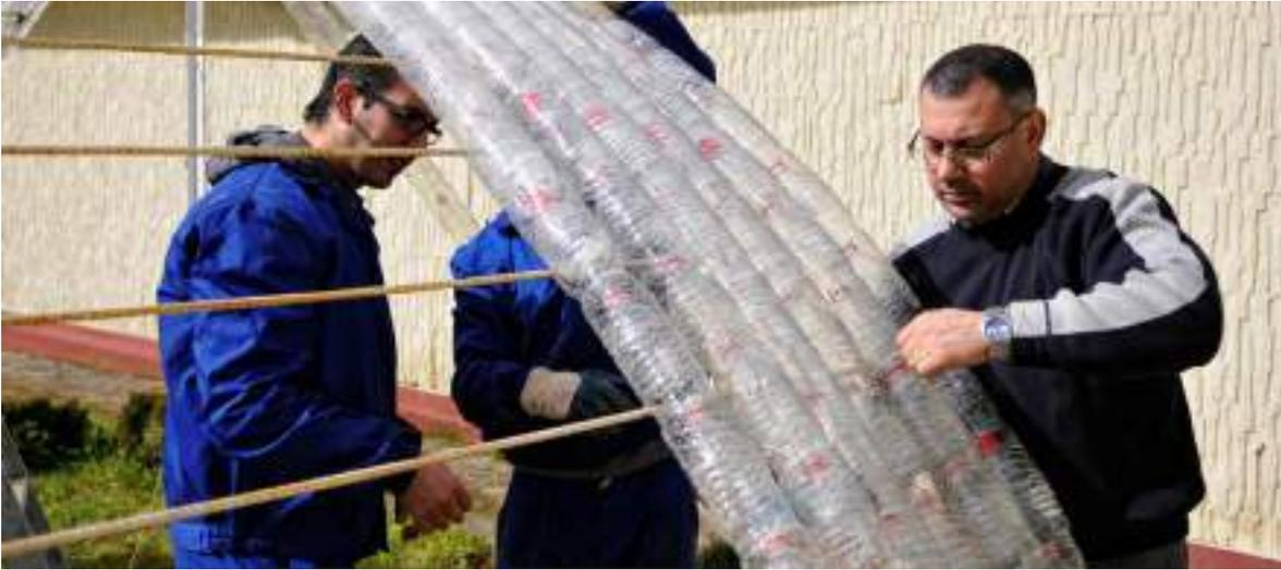
A continuación, con la cuerda se va rodeando cada fila de botellas para unir cada hilera con la siguiente. Este paso lo repetiremos cada dos botellas de la fila y se pasará la cuerda por la zona de unión entre botellas para reforzar la misma y mantener la estructura lo más compacta posible.
