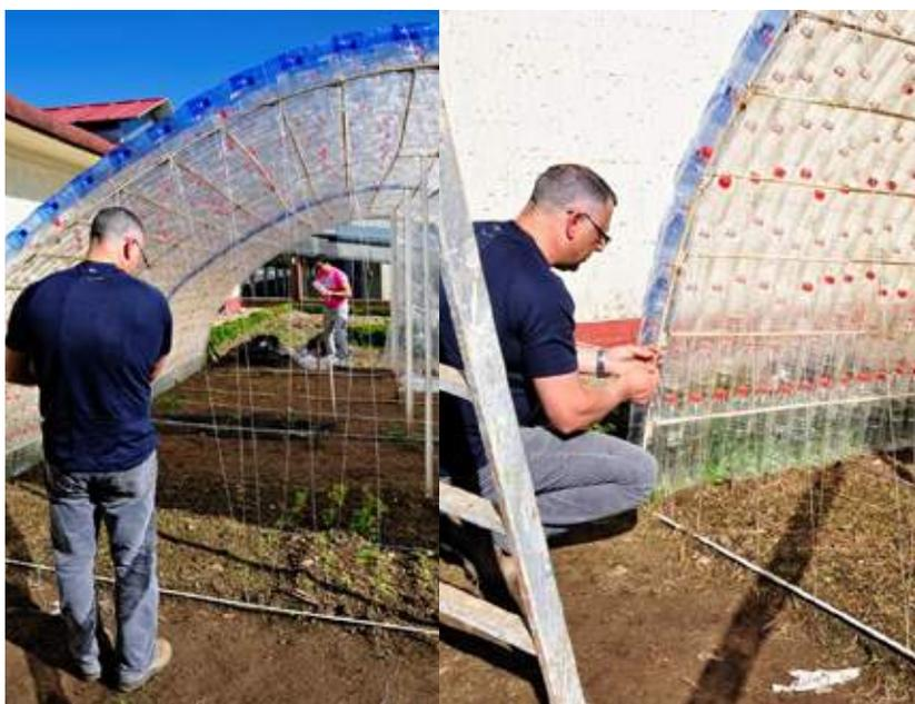
Con los hilos desplegados, vamos colocando y fijando el plástico previamente elaborado.
