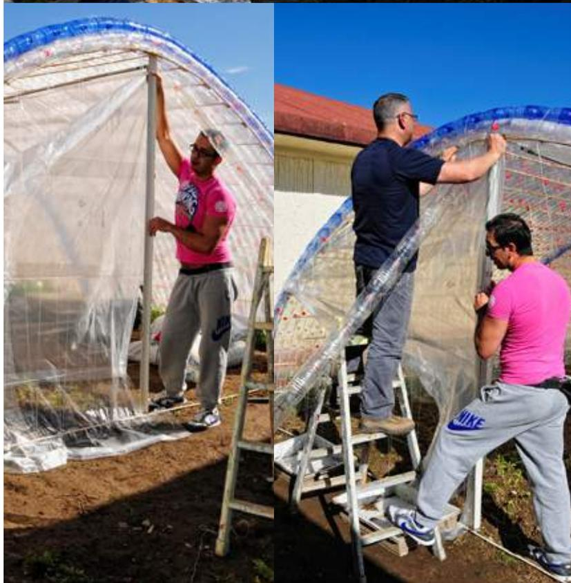
Mediante cuerda, vamos fijando la cubierta de plástico a los laterales del invernadero hasta completar y cerrar toda la superficie.
