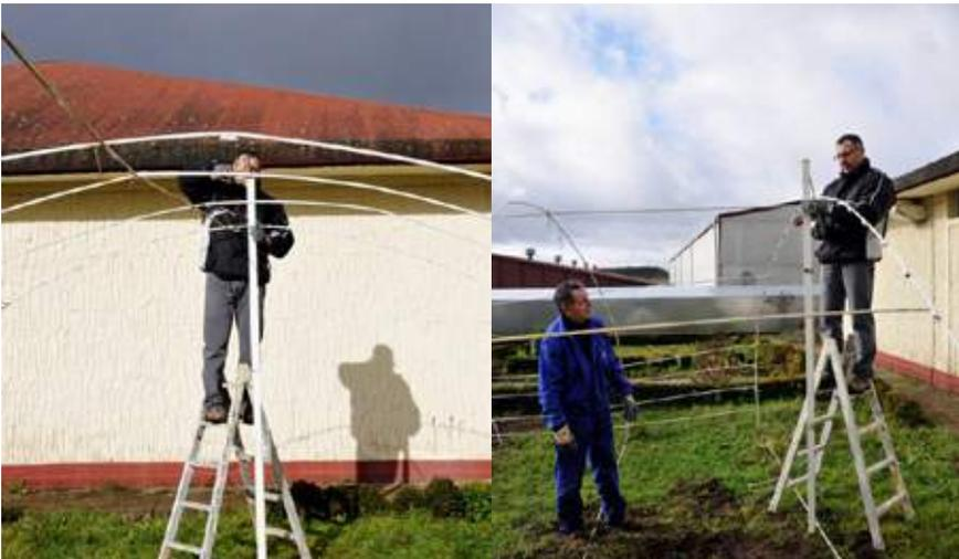
Procedimos a medir con precisión la ubicación de los 5 puntales que sustentarán la estructura para realizar de otro modo los agujeros con la profundidad suficiente que nos permita adaptarlos a la estructura del invernadero y a colocar las barras laterales que den la consistencia necesaria hasta conseguir la herramienta que nos permita fijar los puntales.
