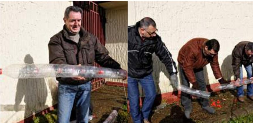
En principio, decidimos colocar un tapón cada 5 botellas (hay campañas específicas de recogida de tapones); pero comprobamos, en las primeras pruebas que realizamos, que la estructura quedaba algo endeble y era difícil de manipular sin aplastar el plástico, por lo que finalmente hemos puesto un tapón cada dos botellas, lo que nos hace mucho más compacta cada fila de botellas y así no se deforma, tan fácilmente, en su manipulación y colocación en el tejado del invernadero.
