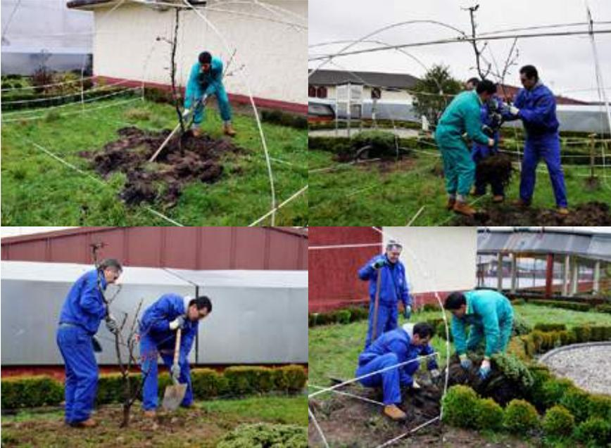
Aunque conseguimos profundizar un poco más los puntales afilados, la dureza del terreno no permitió realizarlo lo necesario para ajustar a las medidas de la estructura.
