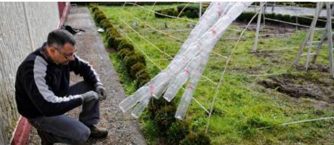
Sujetamos la primera fila de botellas al arco frontal del invernadero con cuerda de construcción, que es la que utilizaremos para todo el trabajo, tanto en el interior de las botellas, como en las uniones a la estructura y entre ellas.
