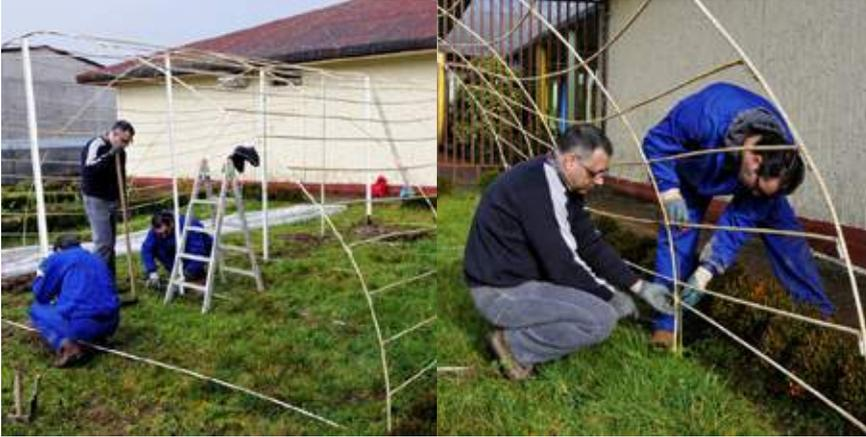
Para fijar la barra a los 3 arcos centrales, lo realizamos con alambre que iremos enroscando alrededor de arco y barra para lograr una estructura sólida y compacta.
