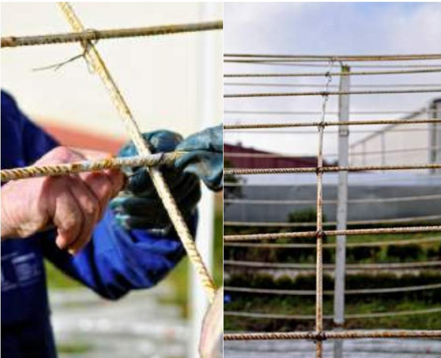
Reforzamos también con alambre los enganches de los arcos frontal y trasero con las barras para evitar que puedan salirse, del mismo modo que hicimos con anterioridad en los arcos centrales, hasta completar, finalmente, la estructura.
